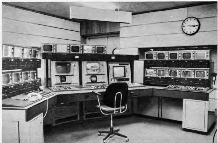
Bild 2. Bedienpult im Bildstern. Im Zentrum der Meß- und Kontrollplatz mit Farb- und Schwarzweiß-Monitoren, Zeilenwahl-Oszillograf und Vektorskop (Aufnahme: Behtke)
